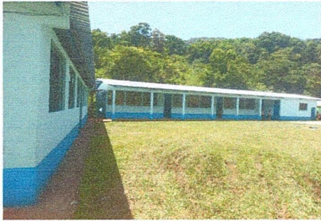
Foto1: Vista Sustitucion completa de cubierta del Establecimiento Educativo.
